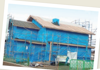
◀ 施工の進捗状況が残せる
